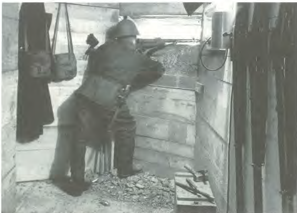
April 1940 – Inneres eines Strassenbunkers.
